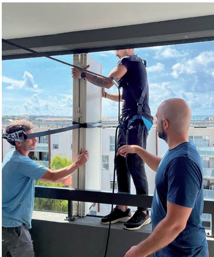
Grâce au SYAM, il est possible de sécuriser le technicien ET le volet pour éviter qu'il ne bascule vers l'extérieur. © SYAM
