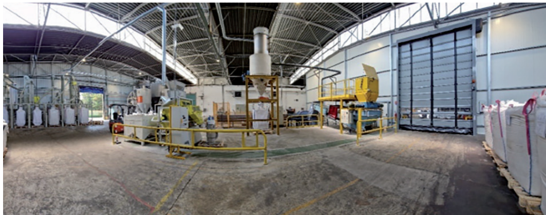
Un des derniers investissements du groupe à Sablé-sur-Sarthe : la plateforme de recyclage des matières PVC, avec table densimétrique, tri-électrostatique et tri-optique.
