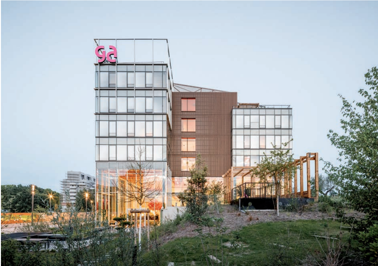
Livré en 2024 et plusieurs fois primé, Niwa est la première tranche du projet de campus tertiaire TMA Newgen (30 000 m 2 ) à Toulouse, lauréat d'un concours remporté en 2020 par Studio Montazami (mandataire) et Tezuka Architects. Longeant la fameuse « Piste des géants », piste historique de l'Aéropostale, le bâtiment de 7 000 m 2 est un démonstrateur de la construction hors-site, mettant en œuvre les savoir-faire en la matière du maître d'ouvrage, GA Smart Building, qui y a établi son siège social. Le bâtiment est labellisé HQE BD (bâtiment durable), BEPOS Effinergie 2017, E3C1 et Biodiversity. ©Photo : 11h45.
