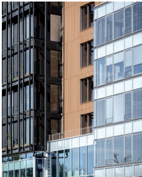
Le bâtiment Niwa décline plusieurs typologies de façades, mises en œuvre par le spécialiste des façades respirantes Paquet Fontaine (groupe GA Smart Building), dont des panneaux préfabriqués de béton, des murs rideaux ou encore des FOB (ossature bois) sur les noyaux d'ascenseur et d'escalier. Certaines intègrent des MTA (Modules de traitement de l'air), des solutions hors site permettant de se passer de centrale de traitement de l'air. Les châssis sont constitués de triples vitrages respirants, avec store intégré lorsque l'orientation le nécessite. ©Photo : 11h45.
