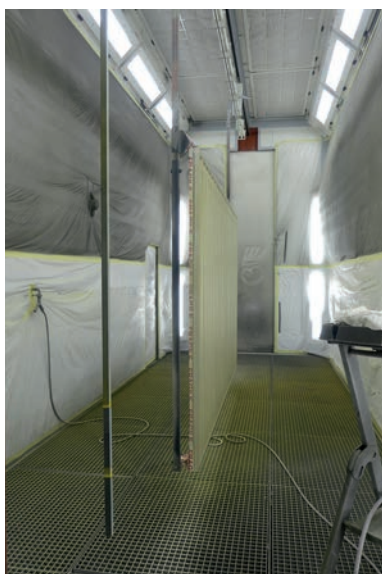
6. Une fois assemblés, les tabliers avec leur cadre passent en peinture dans les deux cabines : pose de la couche d'apprêt en cabine de préparation, pose de la couche de finition et passage en étuve pour cuisson à 60-65°C durant 40 à 50 minutes. L'étuve peut monter jusqu'à 85°C. © PP
