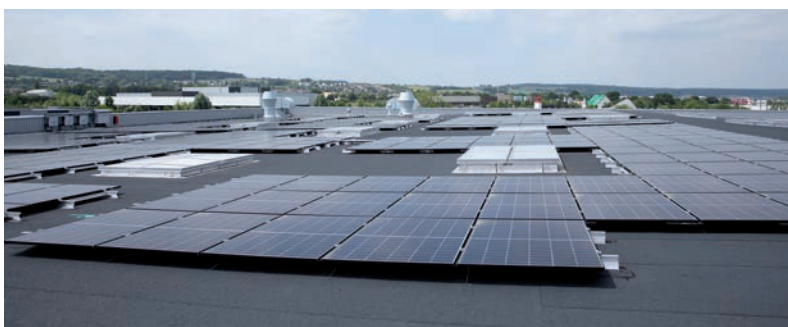
Le bâtiment de production porte 1200 m 2 de panneaux photovoltaïques, soit 236 kWc. La production est autoconsommée avec revente du surplus. Durant l'été 2024, le site était autosuffisant en électricité, couvrant à la fois les besoins de la production et ceux des bureaux. Doc. Accédia
