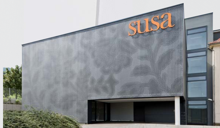
Entrée commerciale (Heubach - Allemagne) membrane composite Soltis FT 371 Maître d'ouvrage Zweckverband Flugfeld Böblingen-Sindelfingen • Architectes (se)arch architekten gbr, Stuttgart • Construction de la façade HVS GmbH, Kleve
