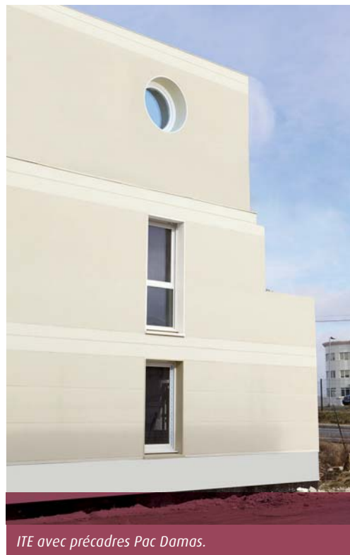
Pac Damas : précadres métalliques sur mesure en acier galvanisé prépeint ou laqué pour ITE et MOB.
