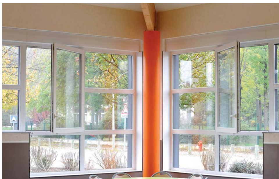
Baies composées de parties fixes et d'ouvrants OB. Veka. Centre de Loisirs de Migennes.
