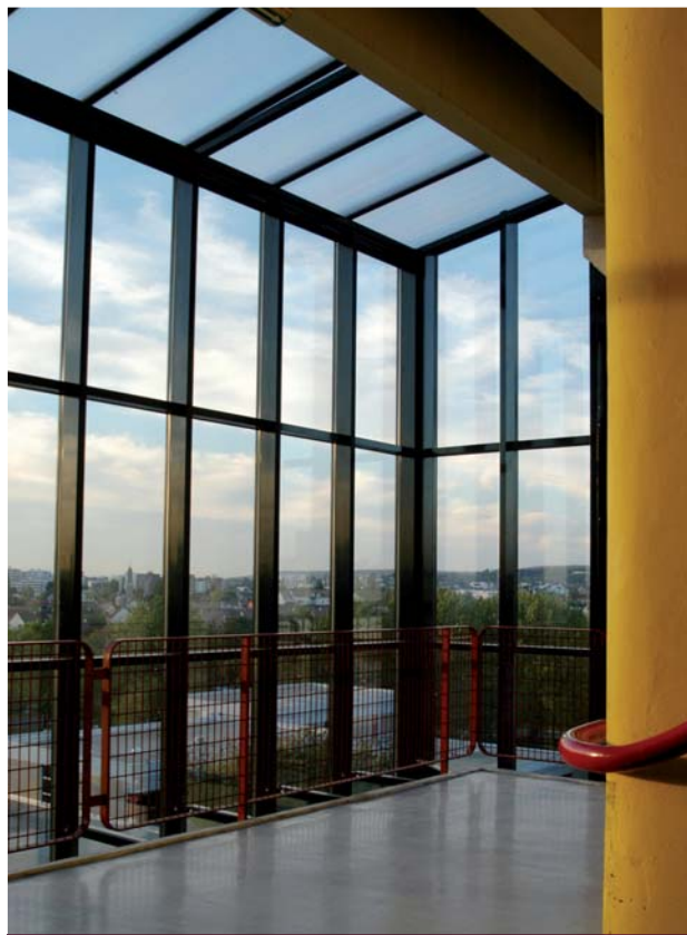
Rénovation de l'Université Paris XIII : belle illustration du système Tanagra de Profils Systèmes. © Laurent Ollier
