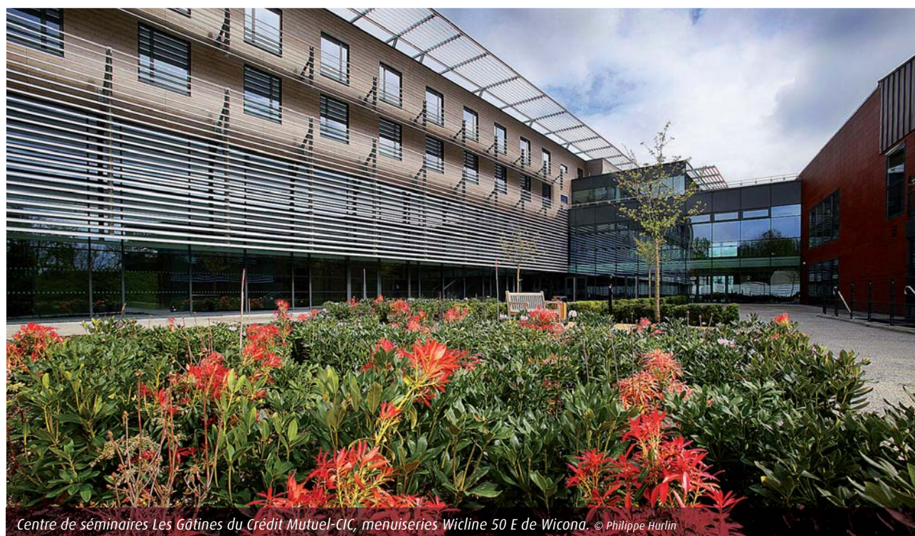
Centre de séminaires Les Gâtines du Crédit Mutuel-CIC, éclairé par les menuiseries Wicona. © Philippe Hurlin
