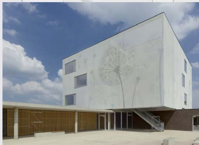
Centre socioculturel et sa halte-garderie KITA (Böblingen - Allemagne) Enveloppe microclimatique de 800 m 2 en membrane composite Stamisol FT 381 blanc avec impression numérique
