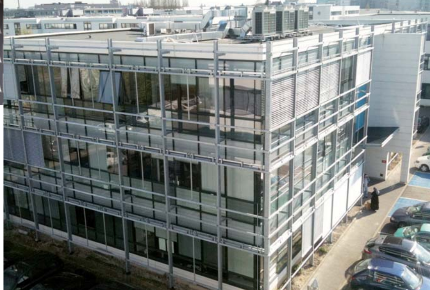
Une seconde façade pour la protection solaire. OFB pour le Conseil Général du Bas-Rhin.
