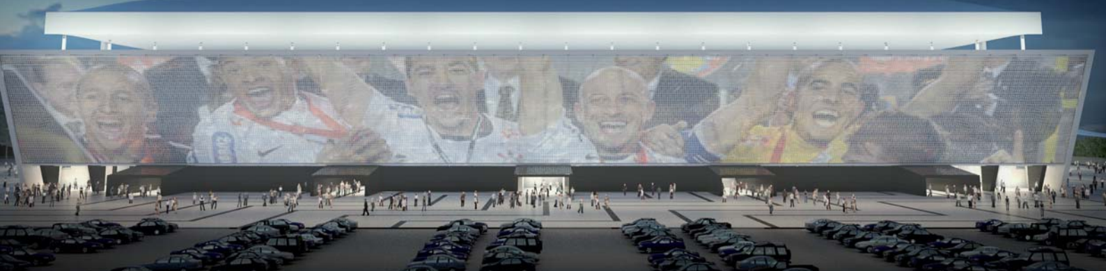
Façade Est de l'Arena Corinthians intégrant le verre AGC Planibel Clearvision. ©Coutinho, Diegues, Cordeiro/DDG.
