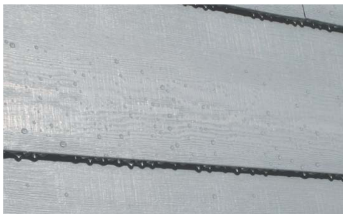
Bardage cellulaire ProCel, PVC à charge minérale, finition gris. Profialis.
