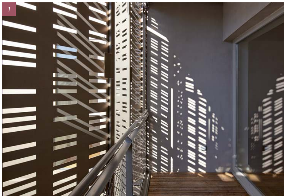
1 - Volets alu pour filtrer la lumière. Atelier du Pont/Élogie. © Frédéric Delangle
