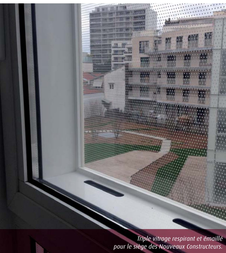
Siège des Nouveaux Constructeurs à Boulogne Billancourt. Architectes Éric Bartolo et Jérôme Villemard.
