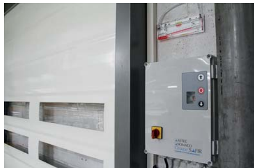
Porte souple pour salles blanches Somaco Planéclair PE120, à indication de pression différentielle. Groupe Safir.
