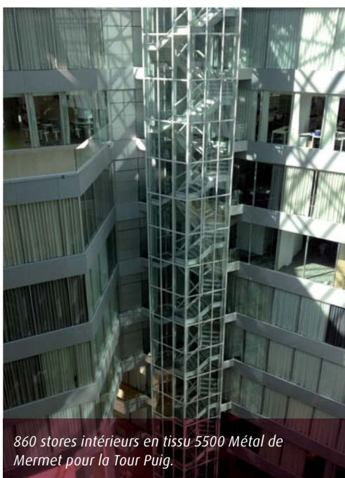
Créée à la façon d'un prisme, la Tour Puig joue avec le soleil.
