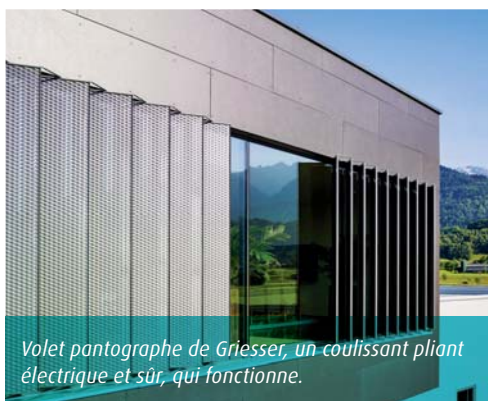
Détail du système de pliage du volet pantographe de Griesser.
