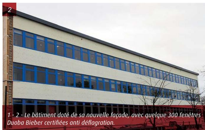
1 - 2 - Le bâtiment doté de sa nouvelle façade, avec quelque 300 fenêtres Duoba Bieber certifiées anti déflagration.
