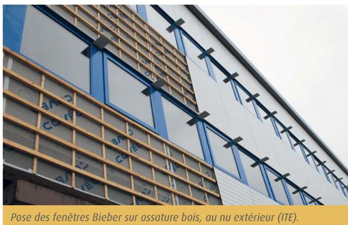
Pose des fenêtres Bieber sur ossature bois, au nu extérieur (ITE).
