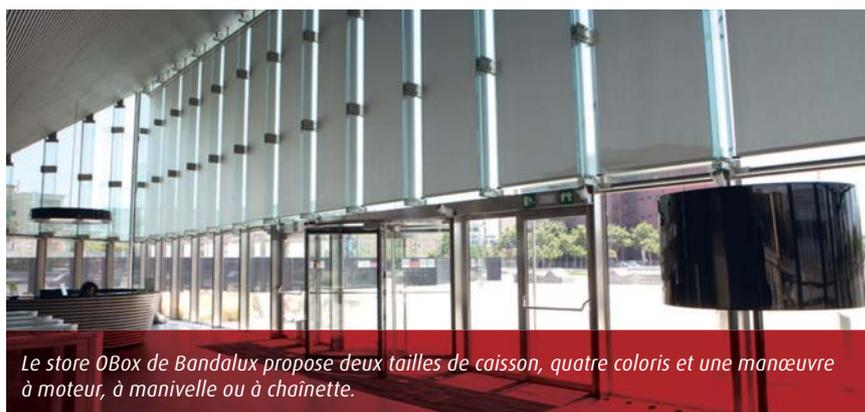
*Le store OBox de Bandalux propose deux tailles de caisson, quatre coloris et une manœuvre à moteur, à manivelle ou à chaînette.*
