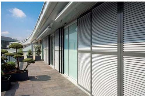
des applications en lame horizontale fixe devant mur-rideau, en casquette avec haubans devant un mur-rideau, ou devant une verrière. La fixation sur des profilés supports à l'aide de pattes en aluminium autorise quatre angles d'inclinaison : 15°, 30°, 45° et 60°.
