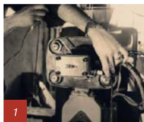
1 - 1958 : outillage d'extrusion pour une lame de volet roulant. ©Profialis 2 - 1980 : atelier d'extrusion. ©Profialis
