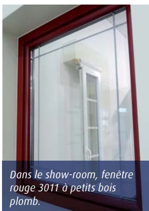
La pose des cales de vitrage obéit à des règles très précises.
