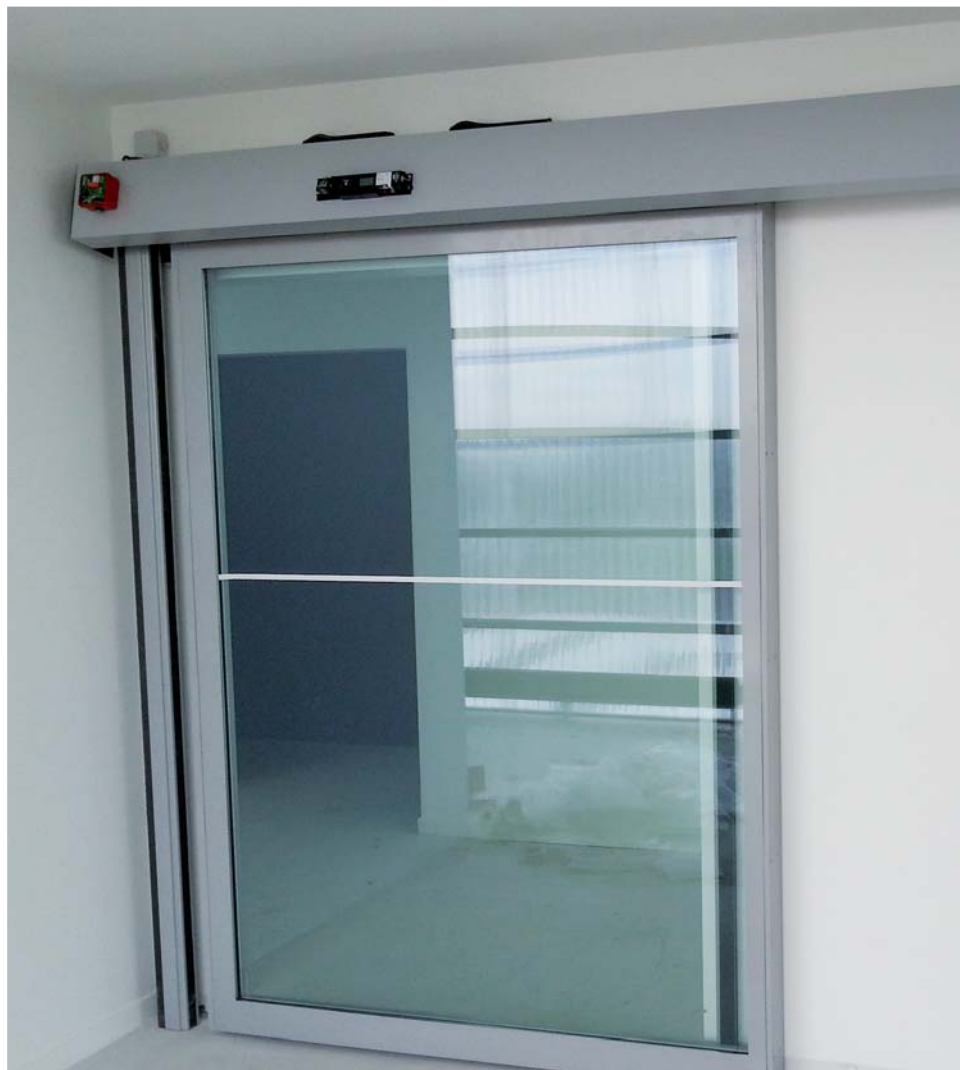
Cette porte coupe-feu est née de l'association de la technologie de moteur iMotion 2401 de Lacroix Portes Coulissantes à la porte coupe-feu agréée MAF Atlantique. Elle répond aux exigences et normes coupe feu 90 minutes ainsi qu'aux normes de portes automatiques piétonnes EN 16005
