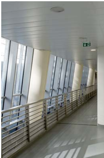
Des coursives à chaque niveau facilitent la maintenance.
