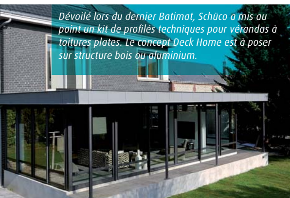
Effet toiture terrasse pour la collection Epure de Véranda Rideau. L'inclinaison de la toiture de 5 % à 12 % est dissimulée par la corniche acrotère
