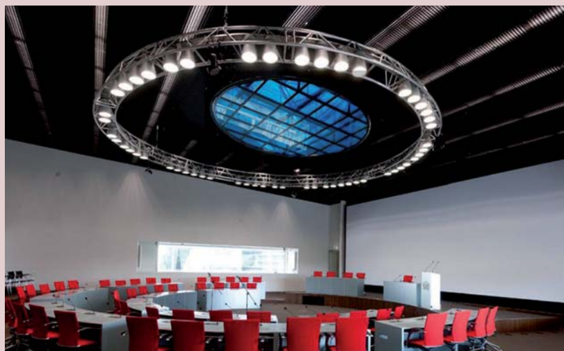
Verrière de la salle des commissions de la province d'Utrecht (Pays bas) équipée de vitrages dynamiques Sageglass®
