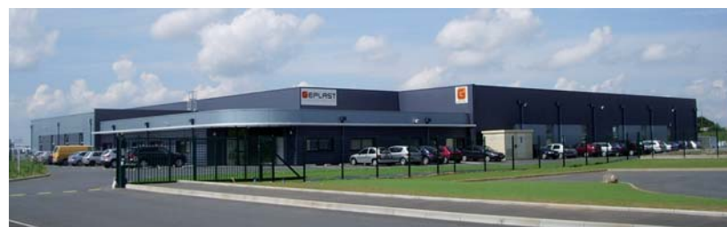
Geplast a encore agrandi son usine (Saint André de La Marche - 49).
